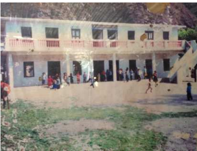
Das Schulgebäude vor dem Erdbeben
